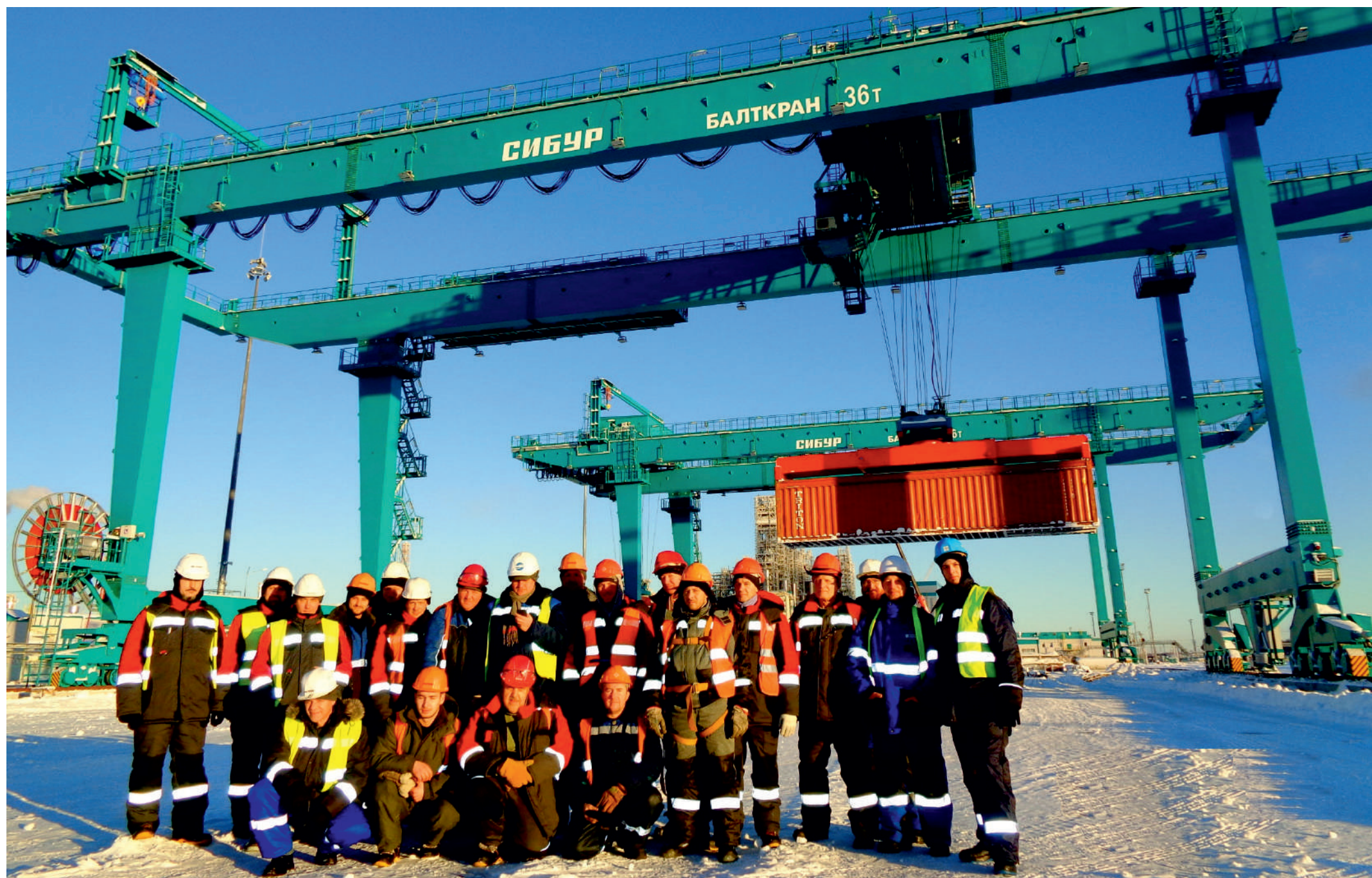
“Сибур”, г.Тобольск, монтаж двухконсольных контейнерных кранов, г/п 36 т., 4 шт.
