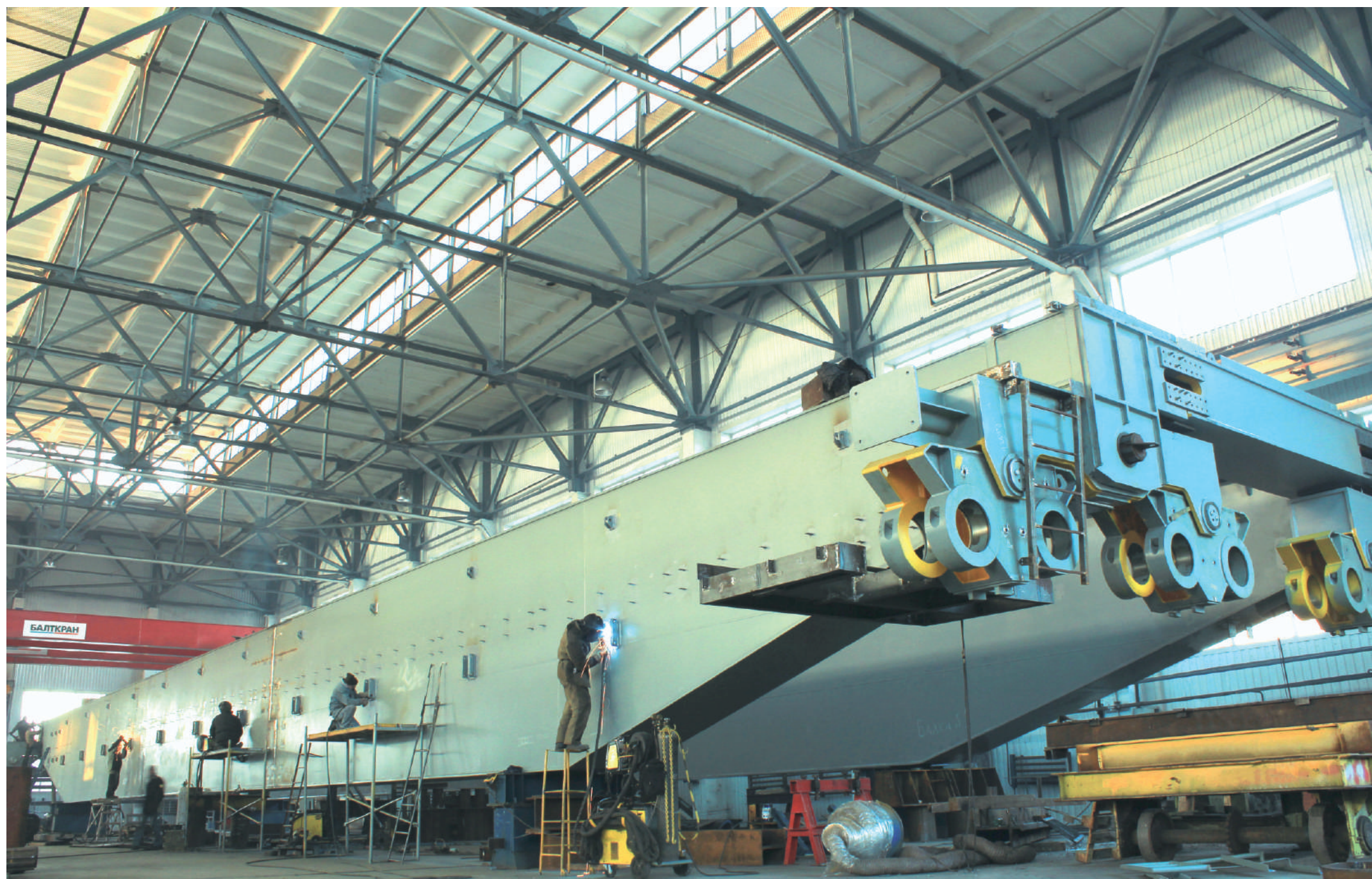
Заводская сборка и тестовые испытания мостового крана г/п 480/32+6,3 т и длиной 50 м
