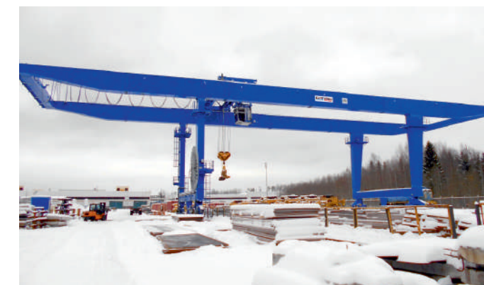
“Caterpillar”, г. Санкт-Петербург, г/п 45 т.
