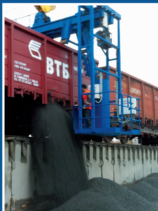
состав на повышенном ж/д пути
